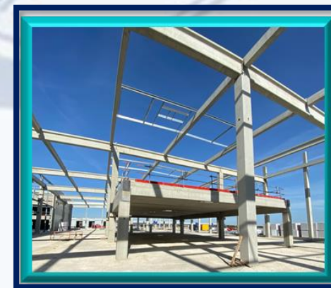
Élément Béton Précontraint Poteau 50 x 50
